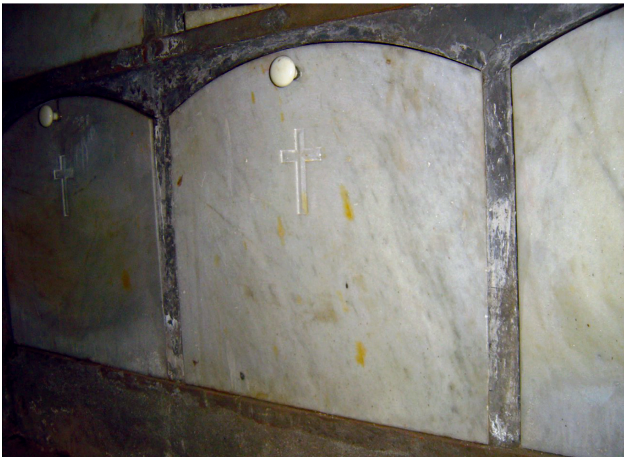
Fòto 23: Detalh dera placa frontau des nichos
