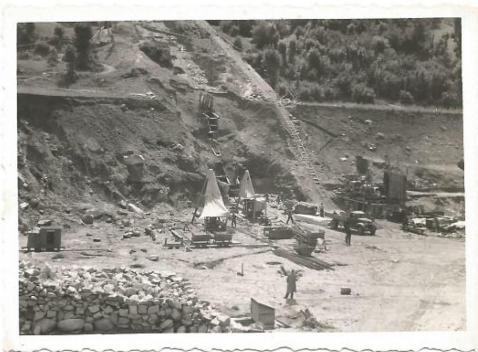
Figura 39. Trabalhs d'aplanament deth prat a on se bastic era centrau.
